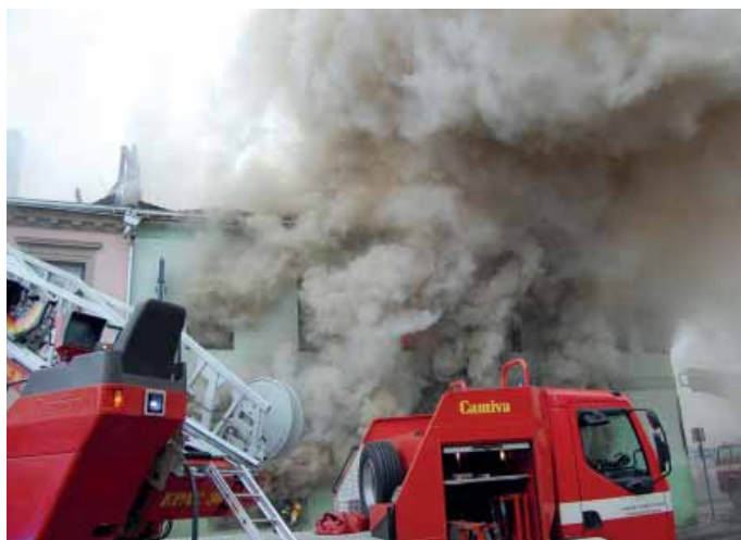
Požár hotelu v Moravské Třebové ohrožoval sousední domov důchodců
