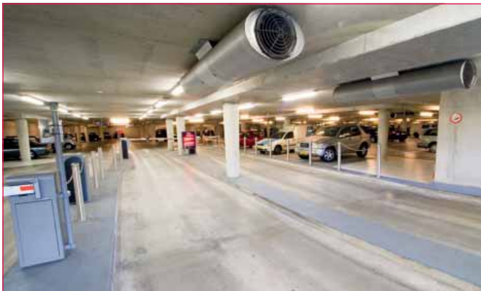
Obr. 4 Ukázka instalace proudových a odsávacích ventilátorů [7]
