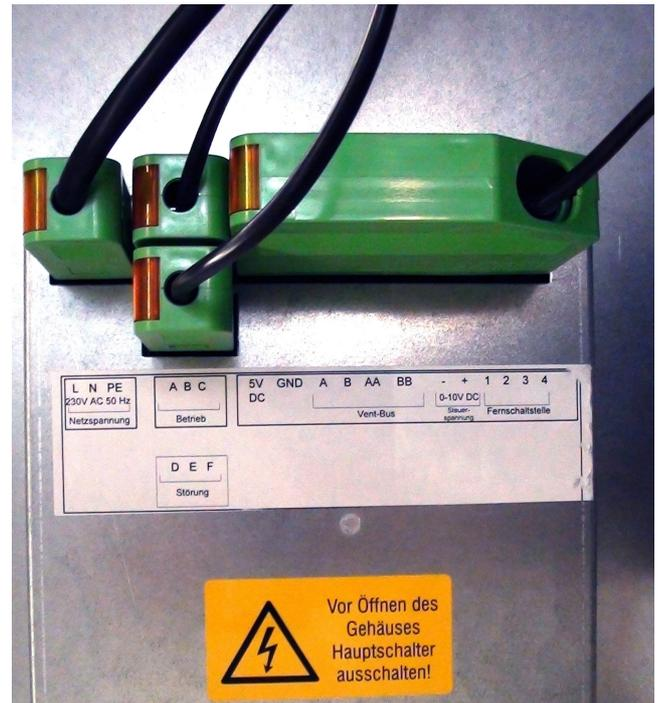
Elektro-Anschlusskasten komplett angeschlossen (nur Netzstecker serienmäßig)
